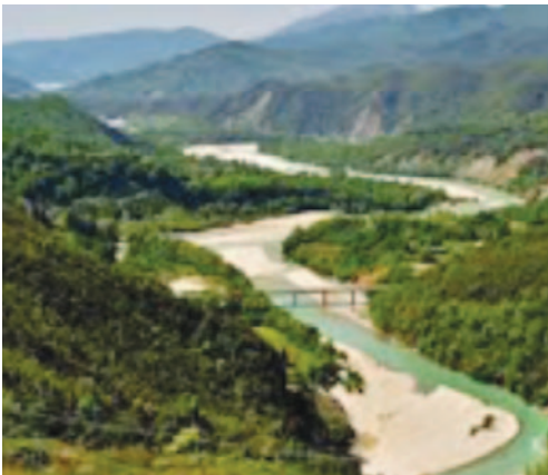
Η γέφυρα Τζαρή στον Άραχθο
